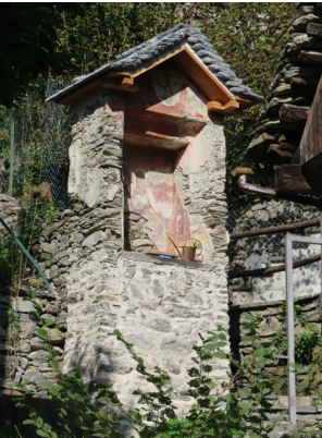
CERCAP22 restauro in corso
